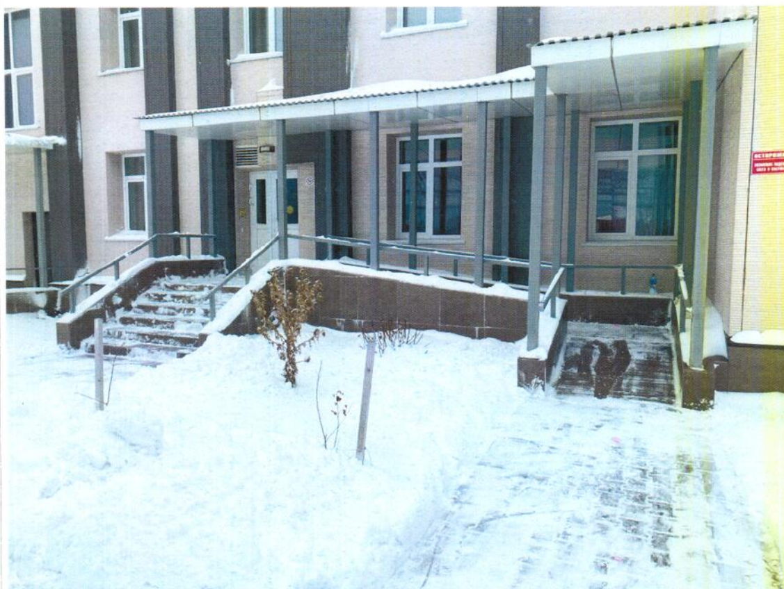
Фото №62 Эвакуационный выход
