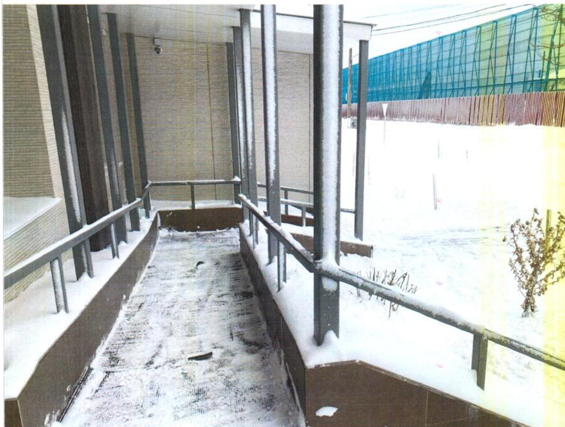
Фото №63 Эвакуационный выход
