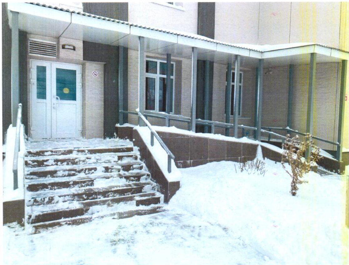
Фото №61 Эвакуационный выход
