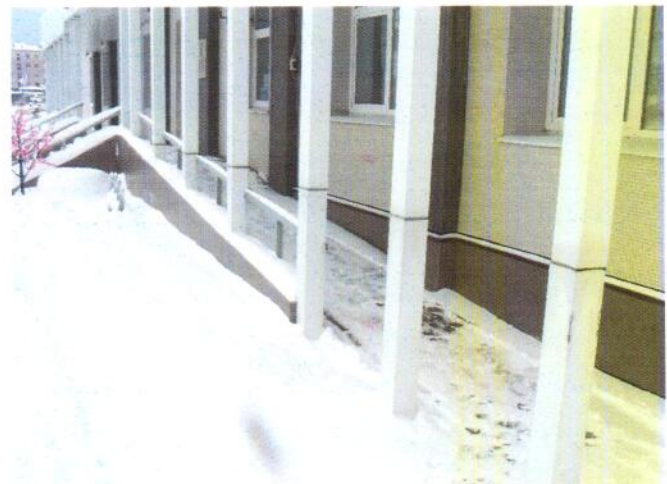
Фото №4 Пандус главного вход (выхода).
